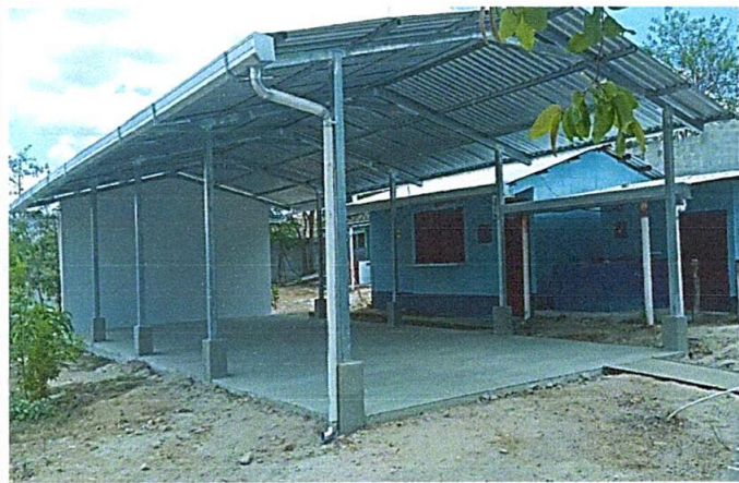
Foto 1: finalización de la estructura tipo pórtico e instalación de lámina troquelada calibre 26 en salón de reuniones y mejoramiento de piso
